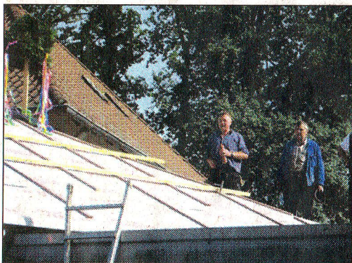
Der Richtkranz weht über der Mensa.
