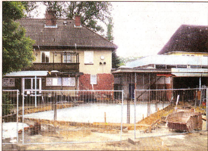
DAS FUNDAMENTt und die Sohlplatte der Mensa sind fertig gestellt. Foto: Ujen
